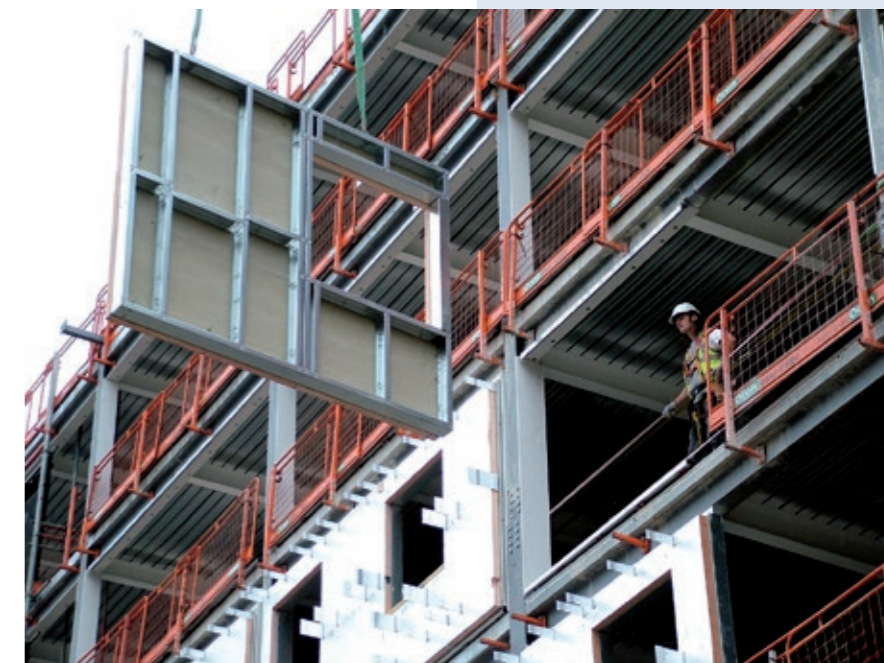
Рисунок 4.1 Монтаж лёгкой стены с внутренним утеплителем к несущему основному каркасу Kingspan Architectural
