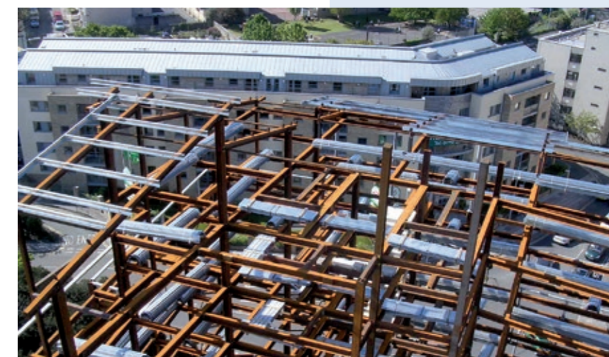
Рисунок 5.1 Стальной каркас из балок с профилем ASB и стальным настилом высокого профиля
