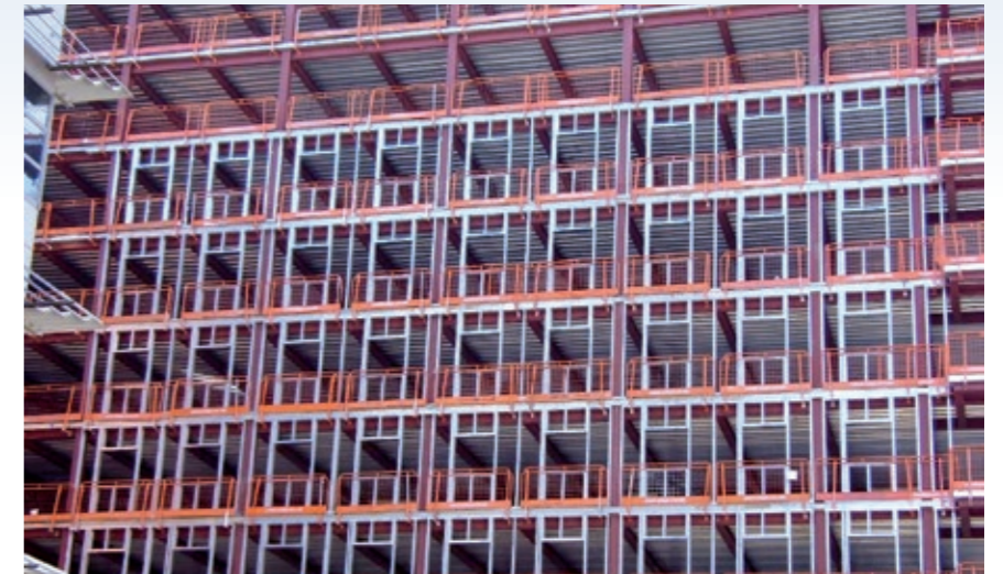
Рисунок 4.4 Стены с каркасом из тонкостенных стальных профилей
