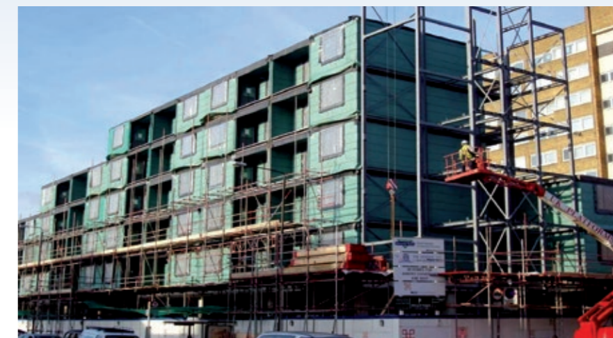
Рисунок 6.5 Модульное здание, установленное на стилобатную часть и зафиксированное системой связей вокруг лестничного блока
