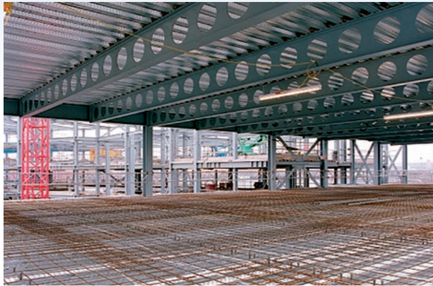
Рисунок 5.3 Композитное сталежелезобетонное перекрытие с применением перфорированных балок
