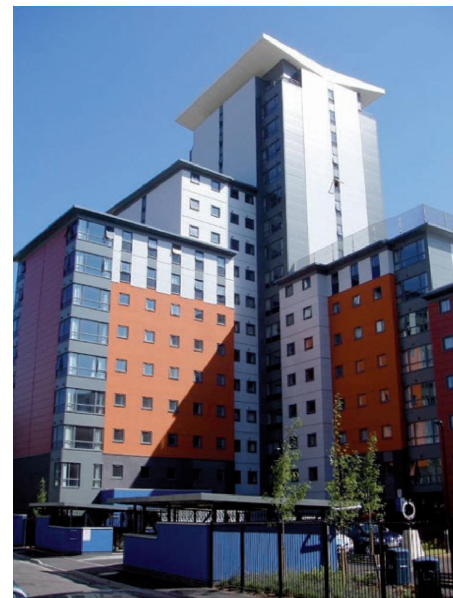
Рисунок 2.2 16-этажное студенческое общежитие, построенное с применением несущего стального каркаса и стен на основе тонкостенных стальных профилей с внутренней изоляцией (Саутгемптон, Соединенное Королевство)
