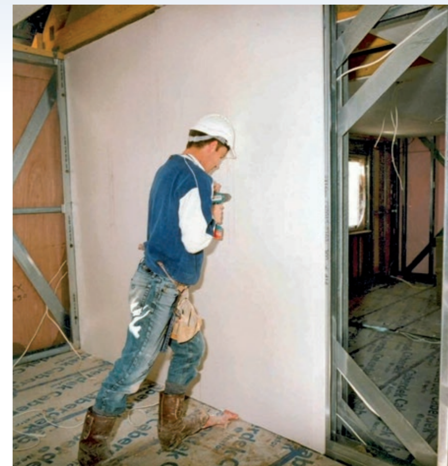
Рисунок 4.5 Гипсокартон, прикреплённый к разделительной стене в месте установки X-образной связи
