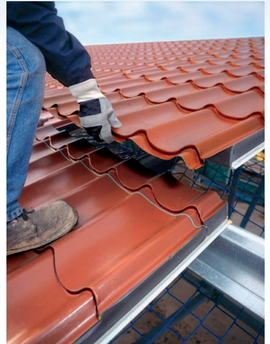
Рисунок 7.8 Монтаж черепичной композитной панели Kingspan
