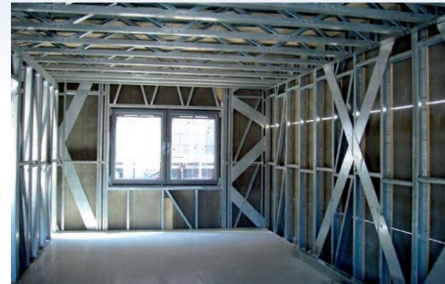
Рисунок 3.3 Решётчатые балки перекрытия с гипсовой стяжкой в большепролётных перекрытиях Metek Building Systems
