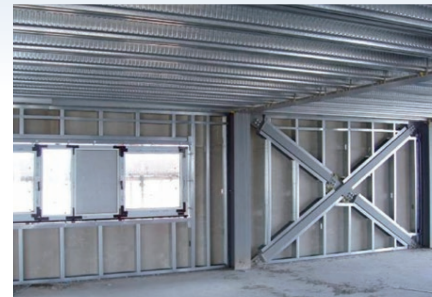
Рисунок 3.7 Стальной каркас с композитной плитой с высоким профилем настила, встроенные в плиту асимметричные двутавровые балки и каркасные стены с внутренней изоляцией
